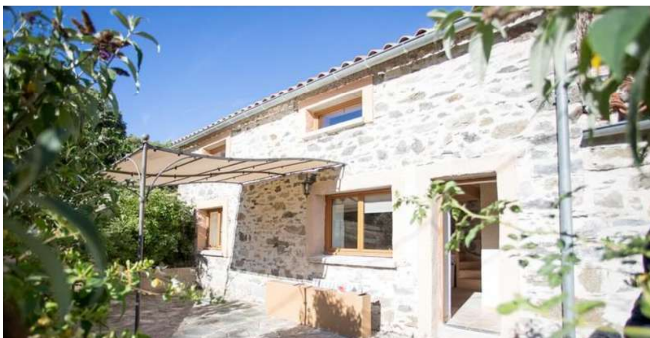
Gîte Le Henson du Pont de Calmel, à Rieussec : nouveau Village de Gîtes labellisé dans l'Hérault.
